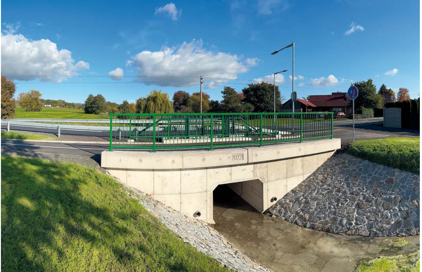
I/14 Ještětice, rekonstrukce propustku
